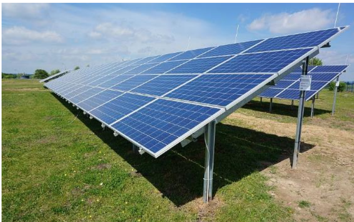
Fot. 6. Przykładowe zagospodarowanie terenu pod oraz pomiędzy rzędami stołów fotowoltaicznych.
